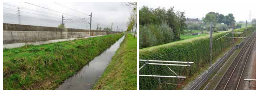
Figuur 12. Geluidsschermvier ten noorden van de Betuwelijn. Alleen ter hoogte van Kerk-Avezaath (rechterfoto) is een deel vergroend met klimop als tegemoetkoming voor de achterliggende bewoners. Voor het resterende gedeelte geldt dat het geluidsschermonbegroeid is en een lange betonnen muur in het landschap vormt.
