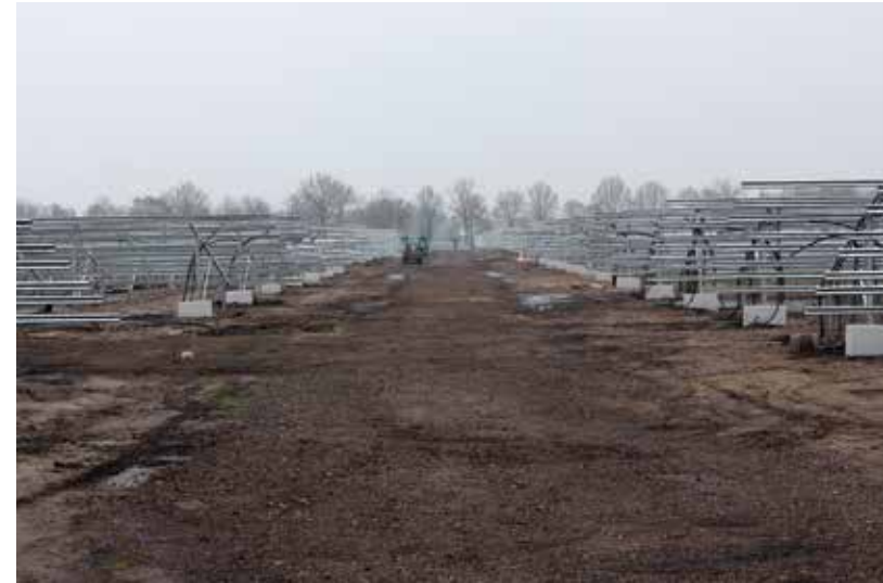
Figuur 17. De middenweg gevormd door asfalt granulaat, noodzakelijk voor onderhoud aan de panelen. De weg is echter zo breed dat men zich kan afvragen of dit echt nodig is. Er liggen hier kansen om het kruidenrijk grasland langs de randen of stapsteengewijs door te voeren. Ook kan worden overwogen om twee poelen te realiseren en/of een smalle sloot, bijvoorbeeld in het midden, met een rijkelijk begroeide oever gedomineerd door grote ratelaar.
