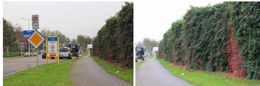
Figuur 11. Geluidsschermdrie de Slangenmuur. Vanaf afrit 33 Tiel inwaarts.
